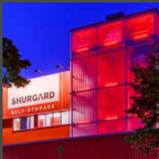
Projekt Project: Lagerhallen | Shurgard Berlin | Aufzugswerke Schmitt + Sohn GmbH & Co. KG, Berlin
