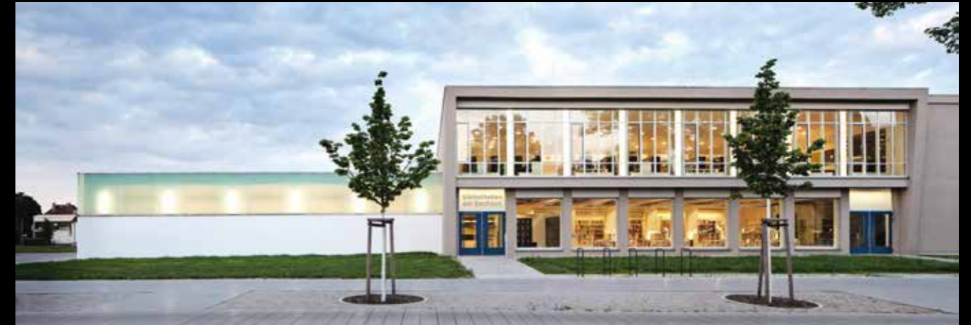
Projekt / Project: Bibliothek am Bauhaus, Dessau, Deutschland / Germany Architektur / Architecture: Reiner Becker Architekten, Berlin Planung / Consultant: Bauer + Zuber, Gräfenhaimichen Fotografie / Photography: Werner Huthmacher, Berlin
