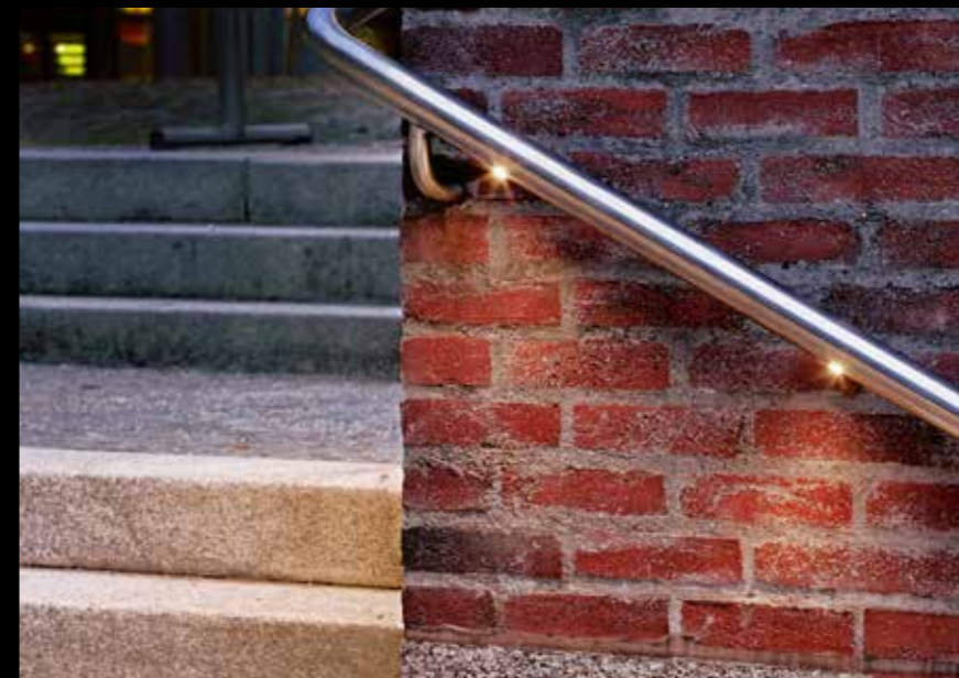
Projekt / Project: Gasteig München, Deutschland / Munich, Germany Planer / Lighting Design: Ulrike Brandt Licht, München / Munich Fotografie / Photography: Hustedt network, Hamburg
