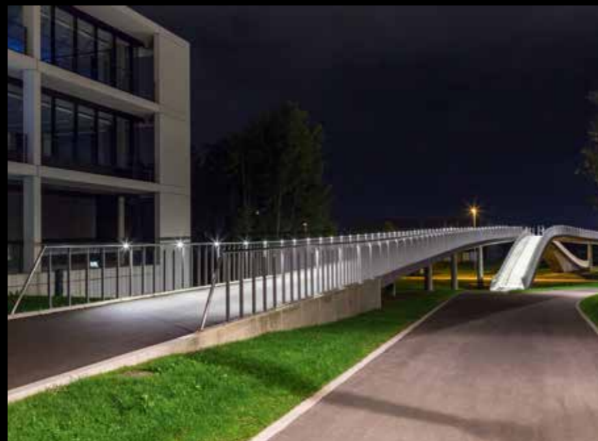
Projekt / Project: Campusbrücke Hublandcampus Universität Würzburg Architektur, Planung / Architecture, Lighting Design: Kolb Ripke Architekten, Berlin / Dr. Schütz Ingenieure, Kempten, Allgäu / POLA Landschaftsarchitekten, Berlin Fotografie / Photography: free2rec / Ignacio Linares, Berlin
